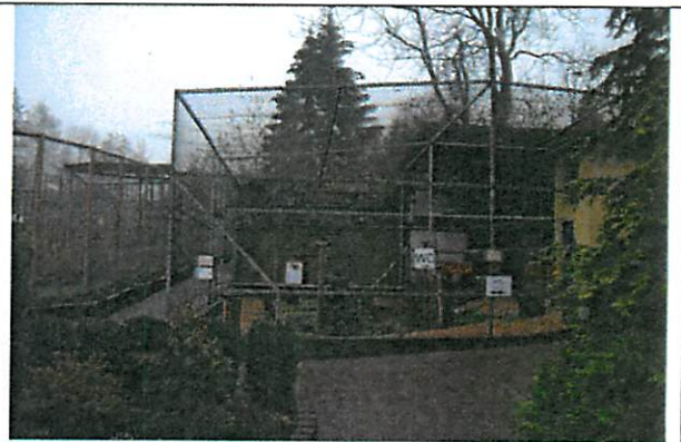
Abb. 7: Flächen des Vogelparks mit Volieren, gepflasterten Weg und gärtnerisch gepflegten Anlagen.
