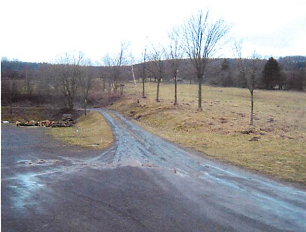
Abb. 4: Böschung mit geschottertem Weg
