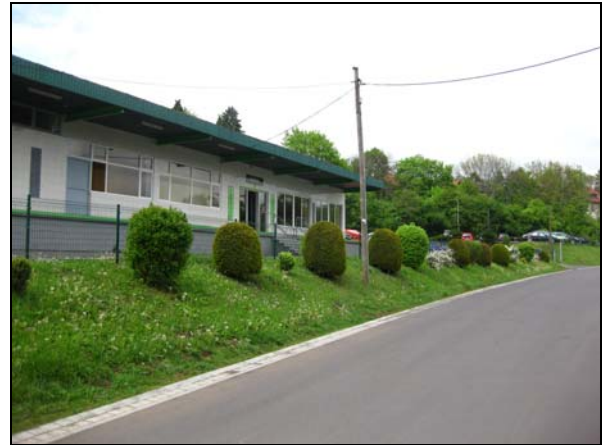
Abb. 2: Halle und Böschungsbereich
