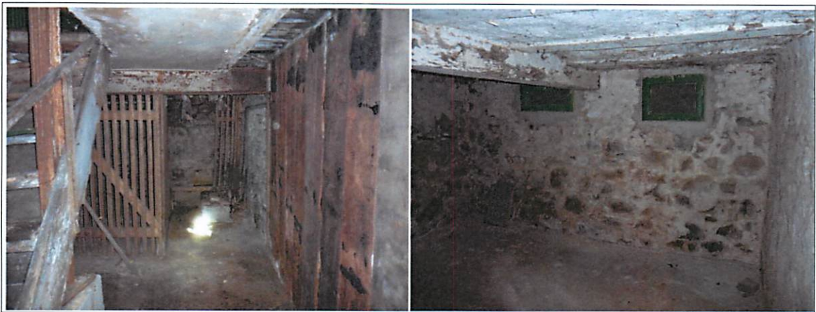
Abb. 6: Keller des abzureißenden Hauses. Gesicherte Kellerfenster.
