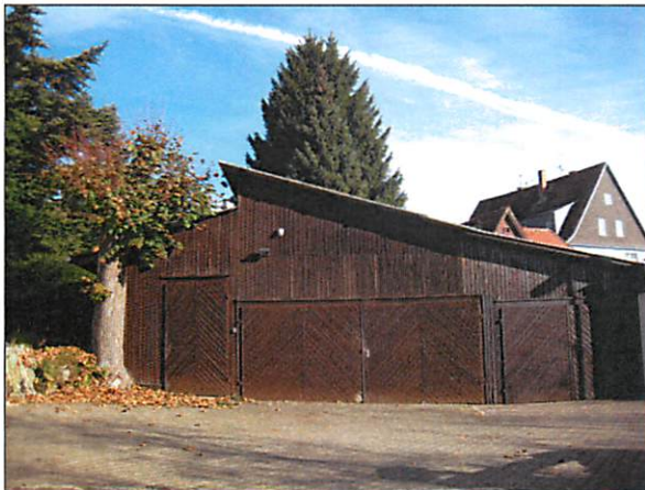
Foto 3: Scheune an Walkmühle
