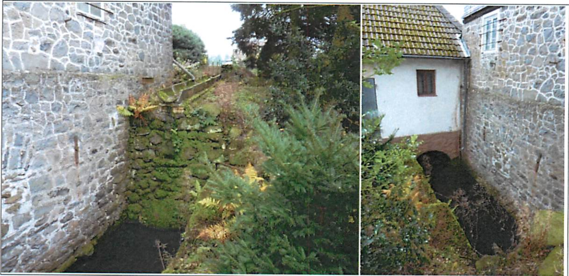
Abb. 10: Absturz zum ehemaligen Mühlrad (links), ehemaliger Mühlgraben (rechts).
