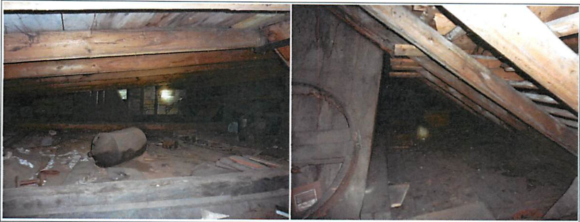
Abb. 5: Dachboden des abzureißenden Hauses.
