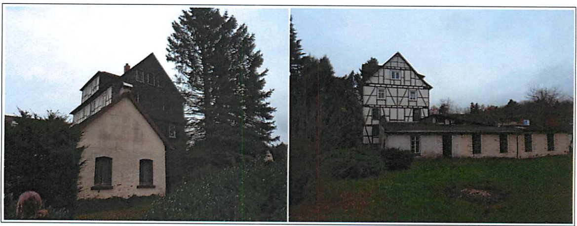
Abb. 2: Nördliches Gebäude mit Nebengebäuden (Werkstatt, schuppenartige Anbauten).
