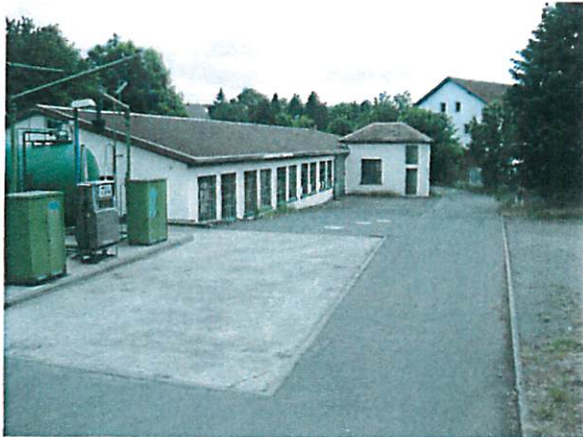
Foto 3: Lagerhalle mit Tankstelle
