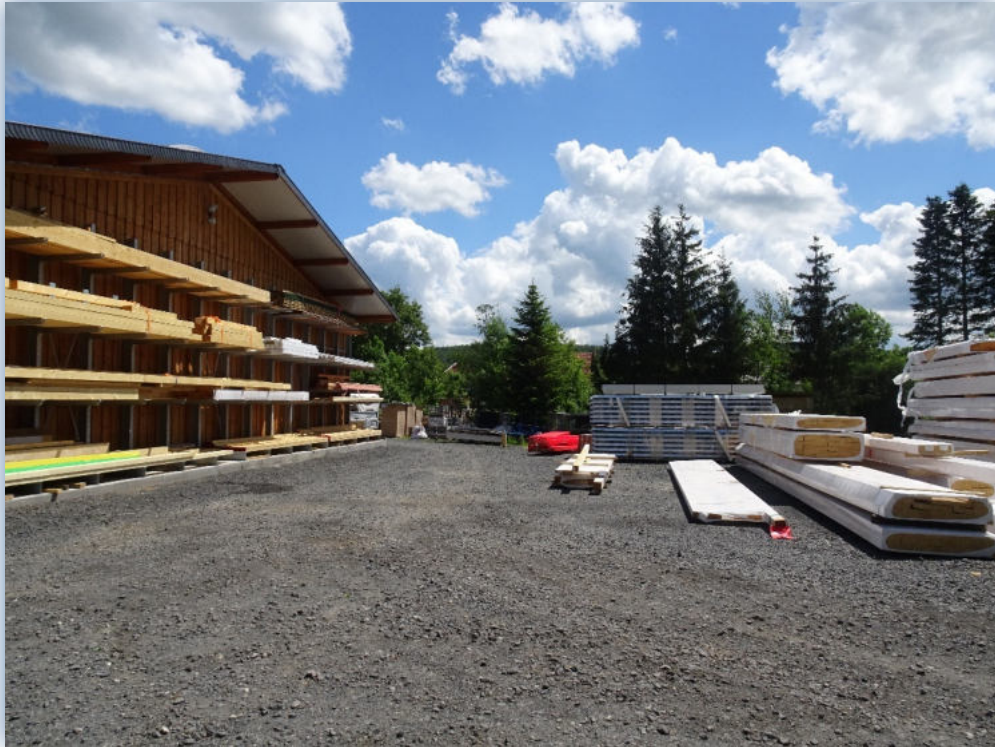
Abbildung 10: Betriebsgebäude und Lagerplatz der Zimmerei
