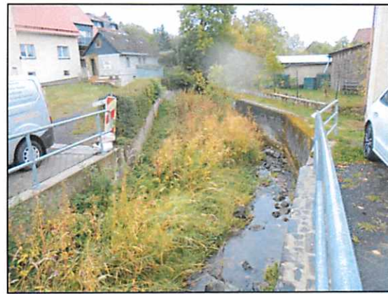
Abb. 9: Östlich am Plangebiet verlaufender, verbauter Eichelbach .
