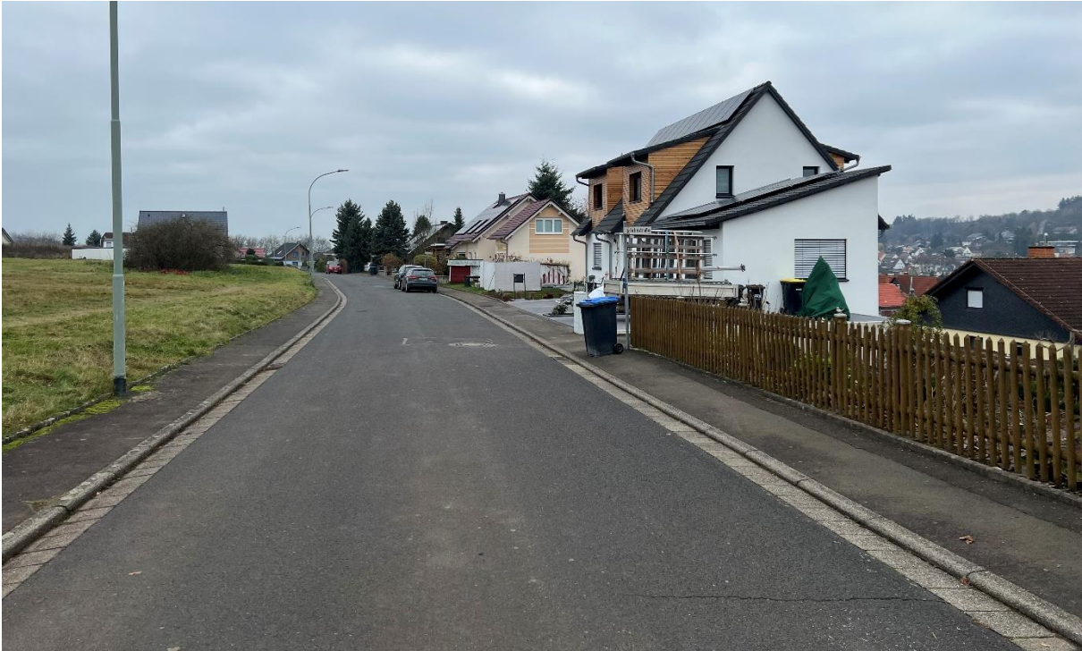
Foto 1: einseitig bebaute Jahnstraße (Quelle: Ingenieurbüro Zillinger, November 2021, Standort: Jahnstraße)
