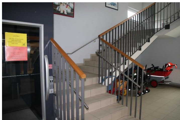
Treppenhaus mit Aufzug und Kinderwagenparkplatz / Nebengebäude
