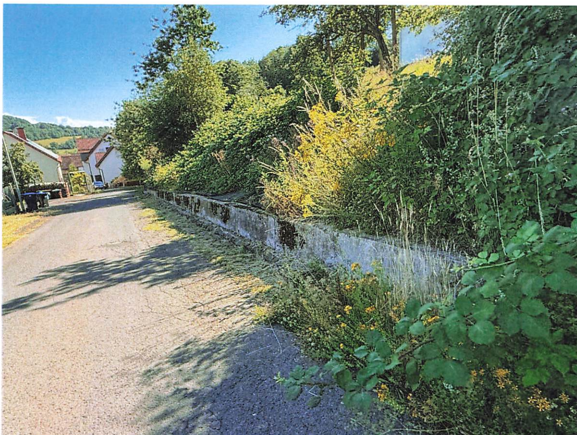
Foto 4: Blick von Norden in Richtung Süden auf den östlichen Rand des Planbereiches (Quelle: Ingenieurbüro Zillinger, Juli 2025)
